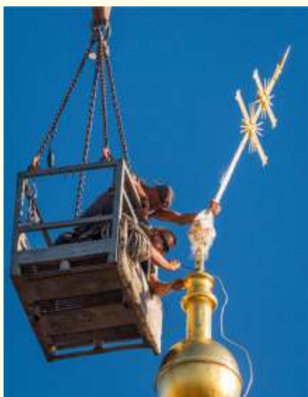
Oprava ohnutého křížku
