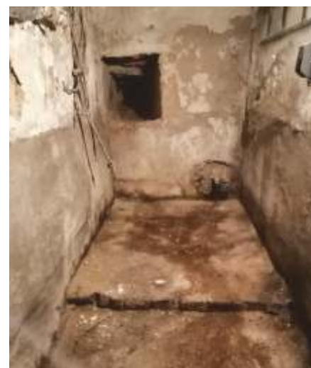
drenážní svod dešťové vody do sklepa
