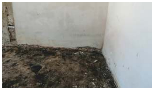
původní stav - mokré zdivo v nově rekonstruované ordinaci a přilehlých místnostech
