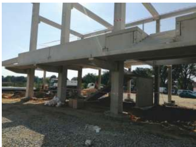
pohled na tribunu a schodiště
