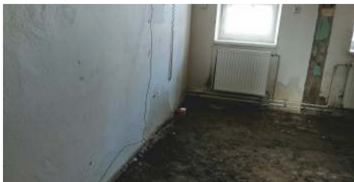
původní stav - mokré zdivo v nově rekonstruované ordinaci a přilehlých místnostech
