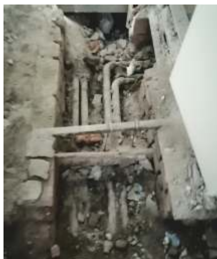
původní stav - mokré zdivo v nově rekonstruované ordinaci a přilehlých místnostech
