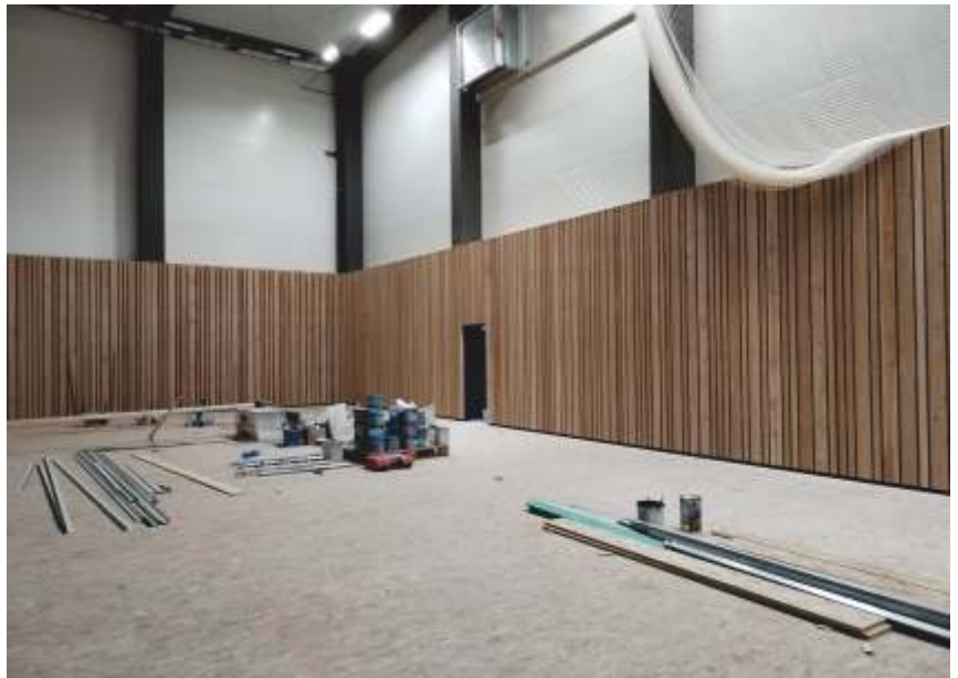
Obložení stěn sportovní plochy
