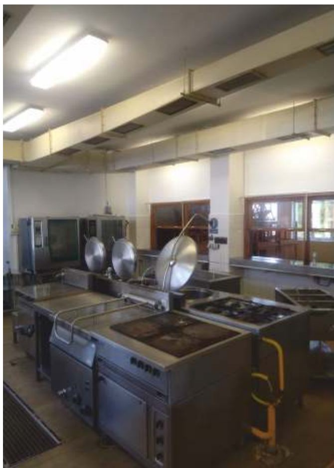
Kuchyně před rekonstrukcí
