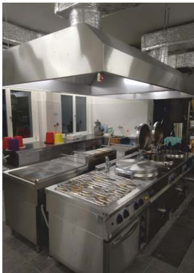
Kuchyně po rekonstrukci - nové osvětlení
