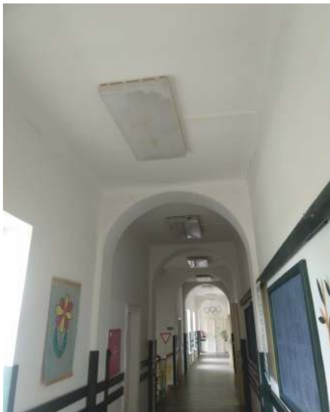
Chodba před rekonstrukcí
