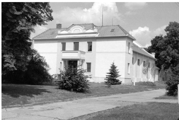
Rekonstrukce střechy budovy Sokolovny
