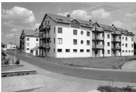
Výstavba 20 bytových jednotek – blok „D“
