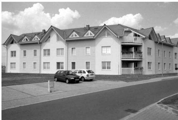
Výstavba 20 bytových jednotek – blok „B“
