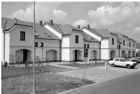
Výstavba 20 bytových jednotek – blok „E“
