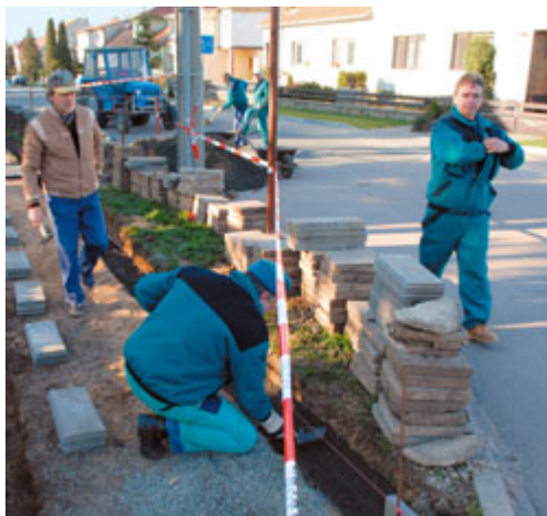
5. 4. 2007 chystáme přeložení chodníku na ul. 9. května
