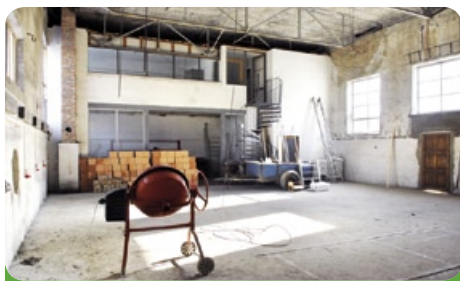
V zimě jsme tuto halu opravili
