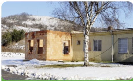
Zde ještě chybí střecha
