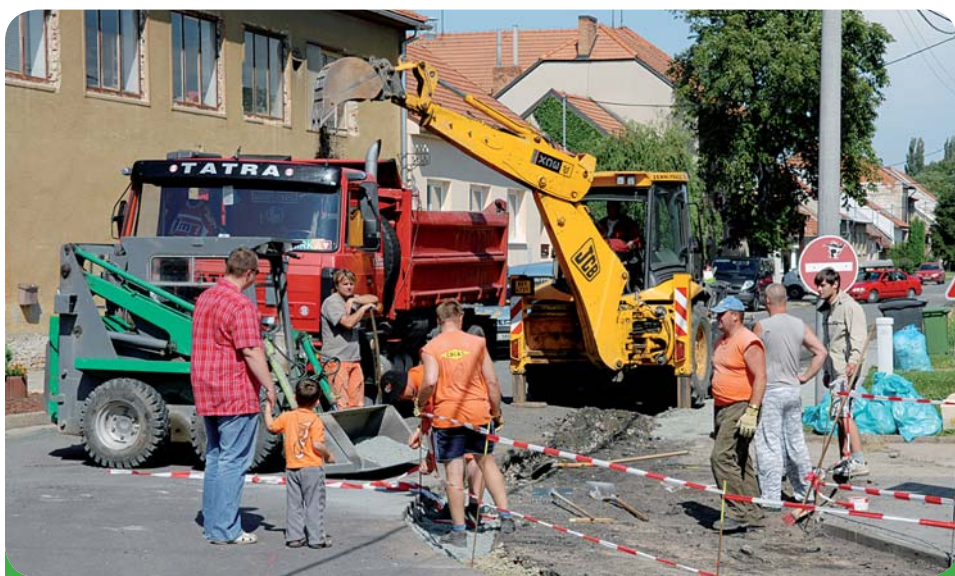
Začali jsme opravu chodníků i vozovky na ul. Štefánikova
