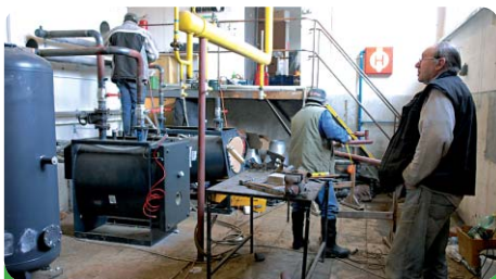
Pan Josef Aldorf řídí rekonstrukci kotelny v mateřské škole
