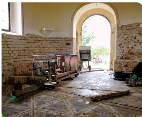
Takto byla podřezávána a izolována kaple sv. Antonína Paduánského.
