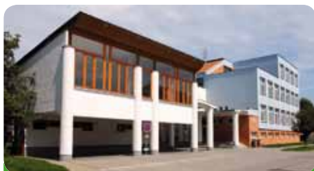
Nová tělocvična základní školy
