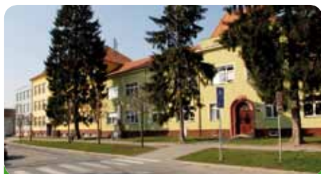
Základní škola po generální opravě
