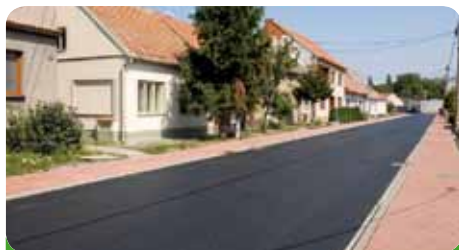
Bylo zbudováno 70 % nových komunikací a chodníků
