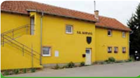
Opravená ubytovna u fotbalového hřiště
