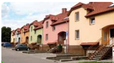
32 bytů na ul. Na Zahrádkách
