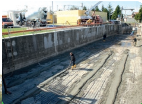
Betonáz dešťové zdrže ČOV
