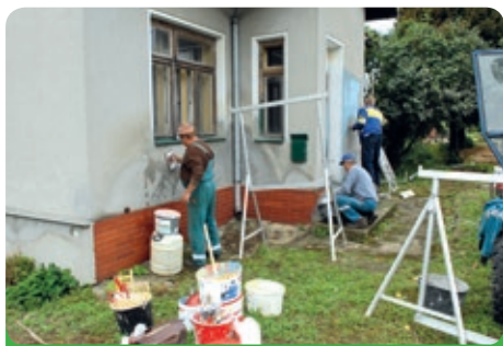
Oprava fasády domku ČSD dne 11.9.2013
