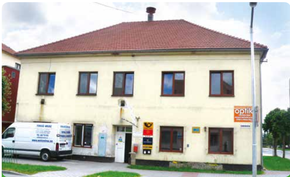
Pošta – probíhající výměna oken, oprava schodiště, zbudování dětské ordinace – klimatizace, 1.720.882,82 Kč
