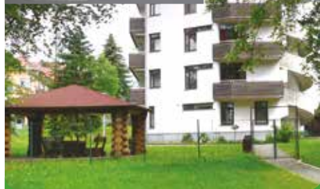
Penzion v nově zrekonstruovaném parku, 1.868.590,84 Kč, dotace ze SFŽP 633.913,- Kč, zbytek hrazen městem
