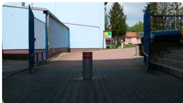
Teleskopický bezpečnostní patník u vjezdu do školního dvora
