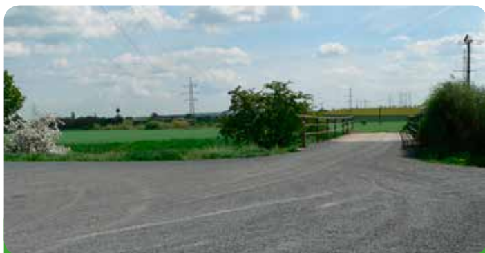
Nová komunikace u šternovského mostu
