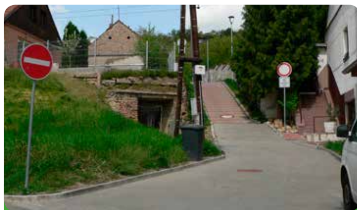
Nová komunikace v ulici Nad Sklepy
