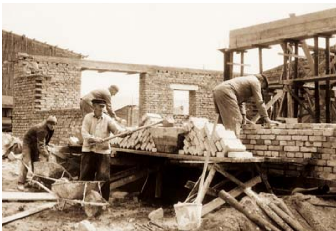
1963 – obchod s cukrárnou v Újezdě u Brna (2004 – Elektro Spáčil)
