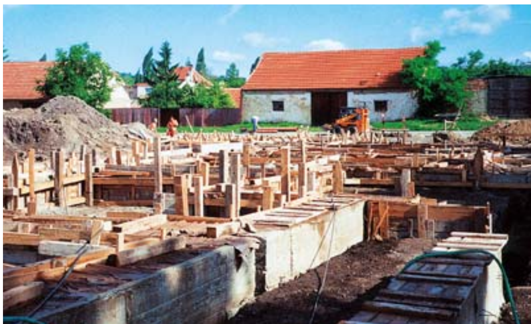
Poklepání základního kamene (ministr Lachnit) a zahájení výstavby DPS – duben 2002
