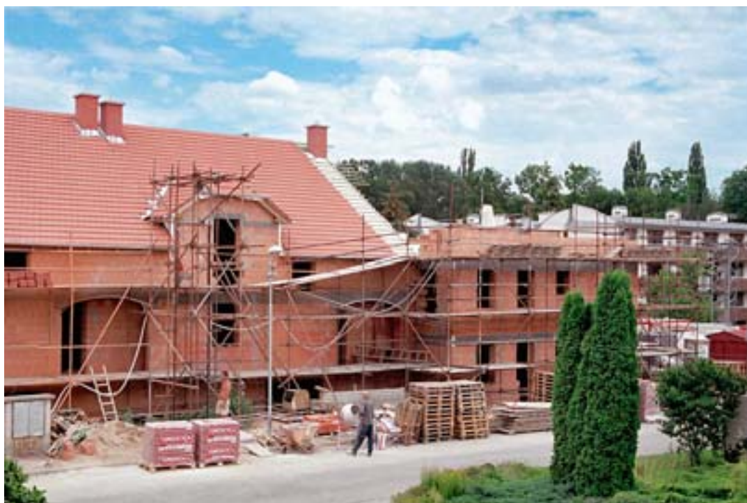
Výstavba bytovky Na Zahrádkách, 2005
