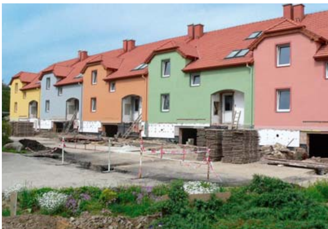
Bytovky ve výstavbě a těsně před dokončením, ulice Na Zahrádkách (ing. arch. L. Tupá)
