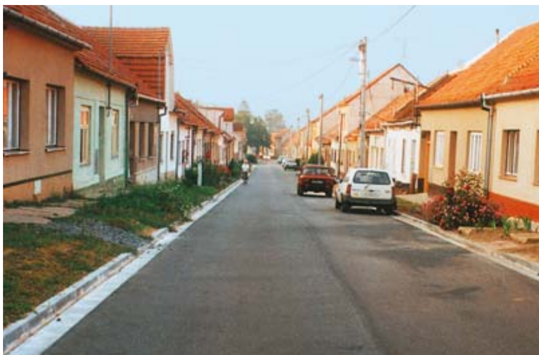
Ulice Revoluční – oprava roku 2001
