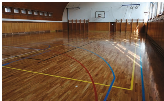
Nová podlaha tělocvičny
