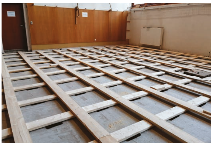
Montáž nového roštu
