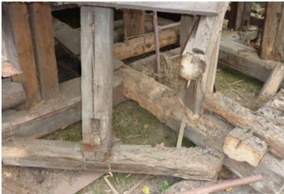
Stav krovu původní konstrukce věže po jejím sejmutí
