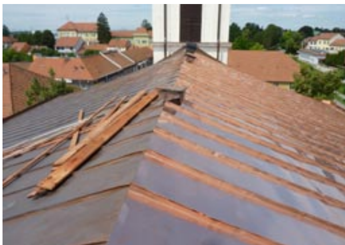
Práce na opravě střechy nad lodí kostela z letošního roku
