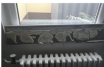
Různá překvapení v podobě způsobu napojení odpadu v kuchyně nebo přilepení parapetu na vymalovanou omítku či obklady
