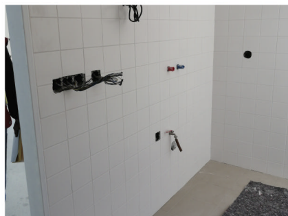
Nové rozvody elektriny a zokruhování teplé vody
