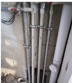
Nové rozvody a odpady
