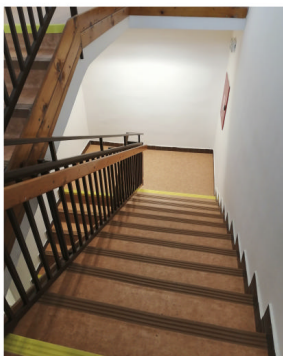
Nové PVC na schodištích
