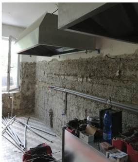
Nové rozvody vody v kuchyni
