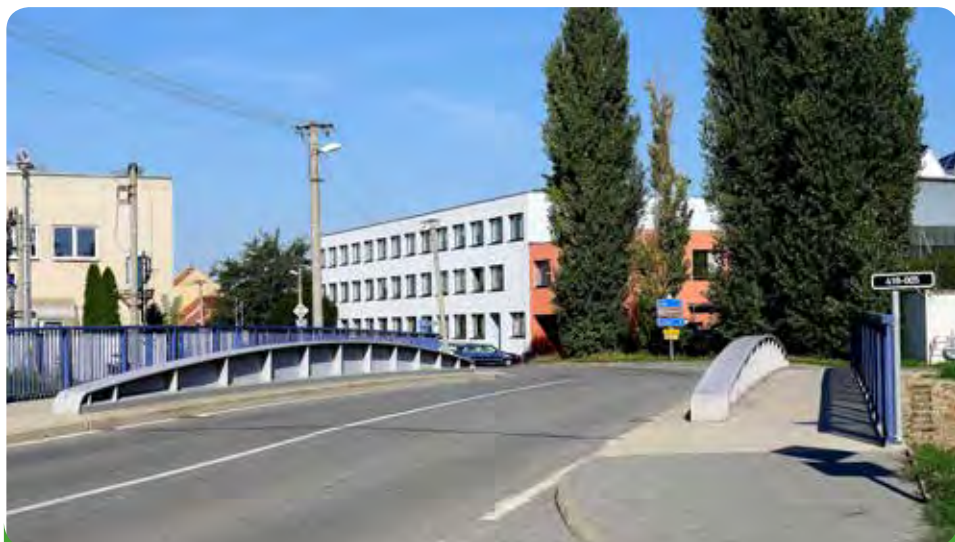
Těžko už si někdo dnes připomene původní most z Újezdu na Rychmanov. Po jednání s JmK zde stojí nový most, který odpovídá stavbám 21. století.
