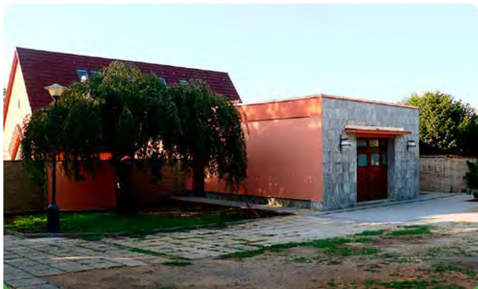
Opravená márnice v areálu hřbitova byla převzata od prováděcí firmy dne 19. 9. 2018.
