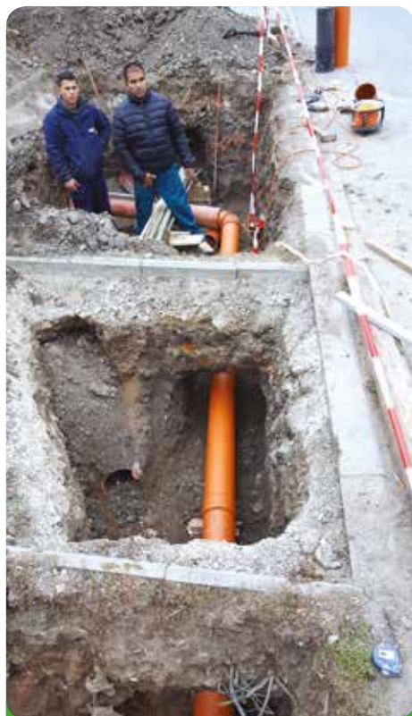
Křížení plynovodních přípojek
