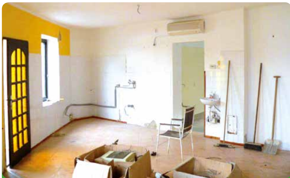
Rekonstrukce bývalé cukrárny
